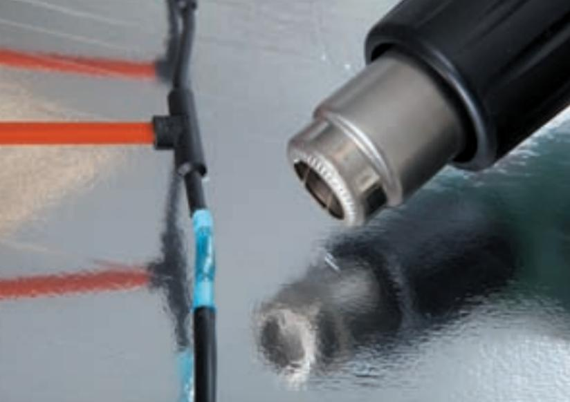
Рис. 12. Термоусадка соединительной гильзы техническим феном
