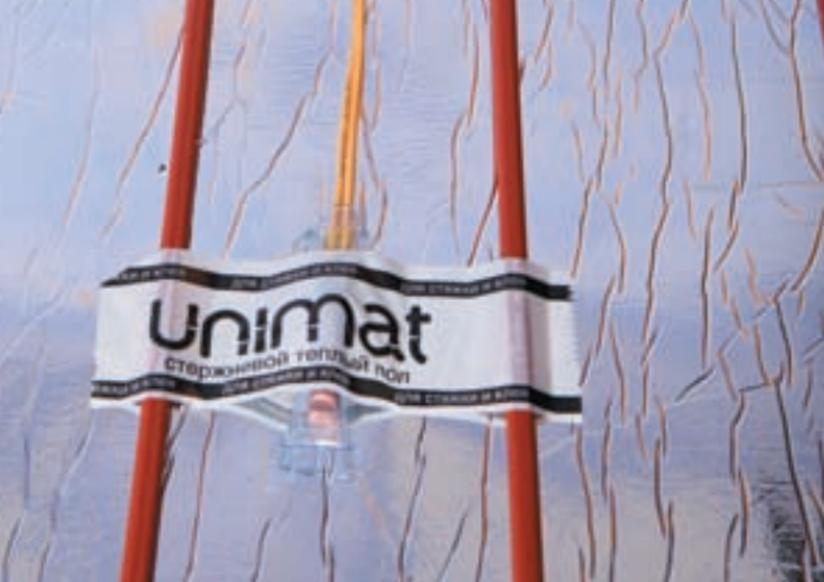
Рис. 15. Установка датчика температуры пола SF 7x30 между стержнями UNIMAT (датчик температуры SU 8x25 устанавливается аналогично).
