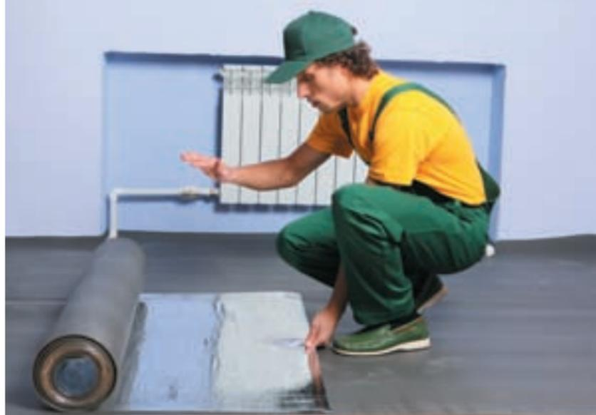
Рис. 2. Укладка теплоотражающего материала
