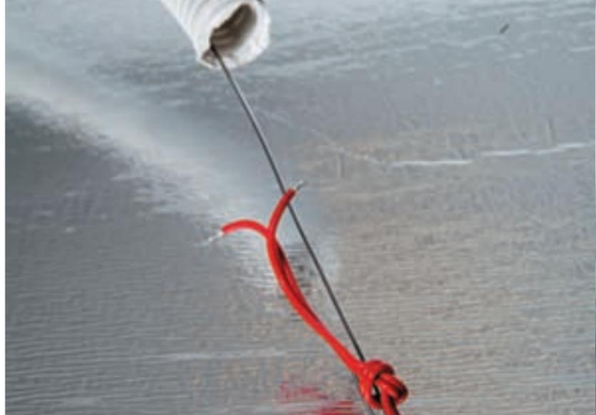
Рис. 16. Установка датчика температуры пола SF 4x15 в гофрированную трубку (начало).
