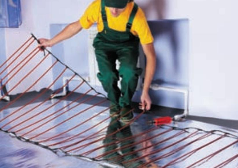
Рис. 8. Укладка разрезанной с одной стороны полосы UNIMAT на теплоотражающий материал с последующим разворотом мата
