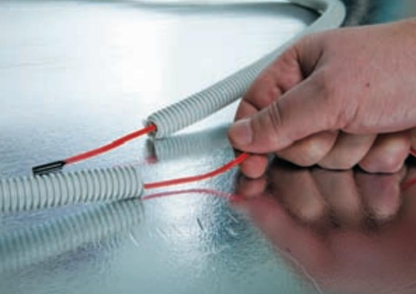
Рис. 17. Установка датчика температуры пола SF 4x15 в гофрированную трубку (конец).
