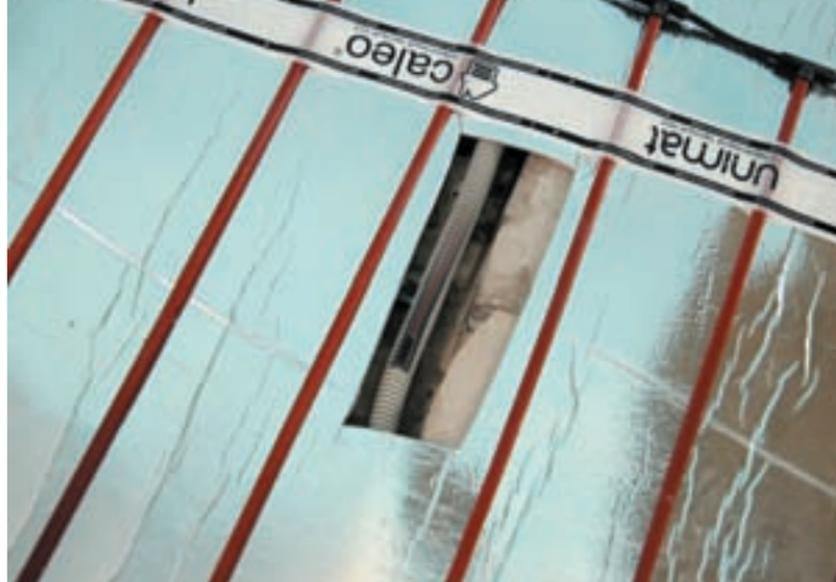
Рис. 18. Установка датчика температуры пола SF 4x15 между стержнями UNIMAT в гофрированной трубе
