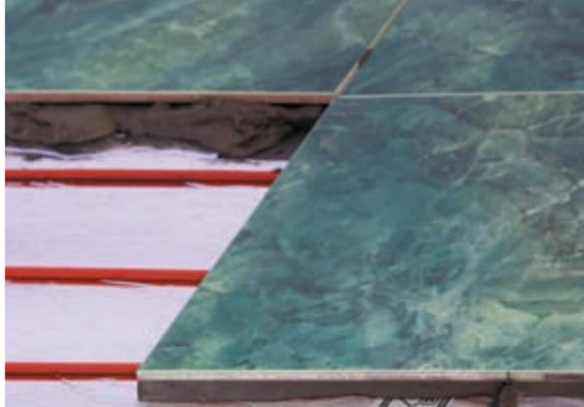
Рис. 25. Монтаж керамической плитки поверх карбонового мата UNIMAT
