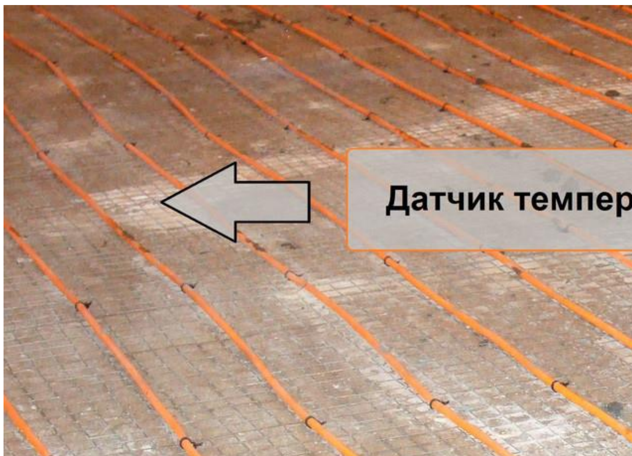
Рис.6 Датчик температуры теплого пола в середине комнаты
